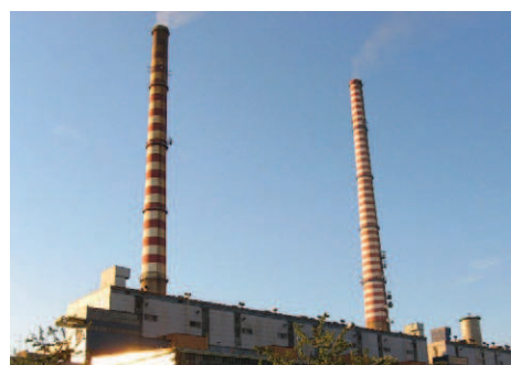
Fot. 1. Kminy elektrowni Rybnik, 260 oraz 300 metrów wysokości.
