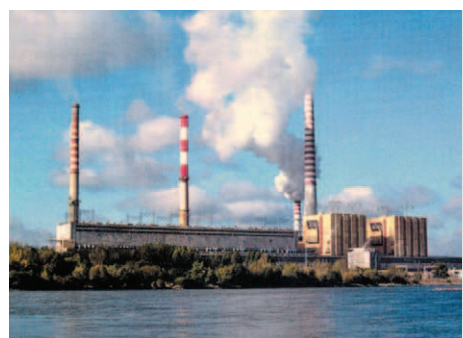
Fot. 2 Kminy elektrowni Kozienice. Najwyższy z kominów – 300 metrów, obecnie w trakcie skracania
