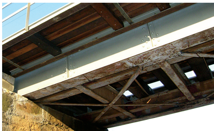
Fot. 1. Typowa konstrukcja spotykana podczas realizacji zadania
