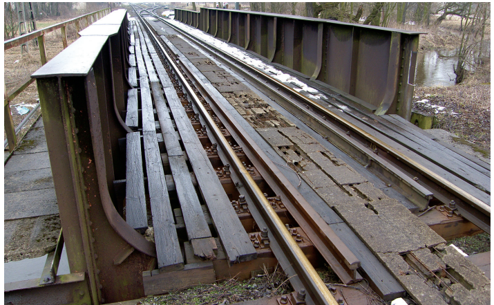
Fot. 2. Konstrukcja mostowa o wysokich dźwigarach głównych
