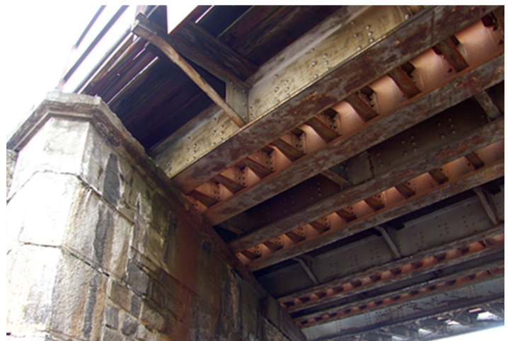
Fot. 3. Konstrukcja o nietypowej budowie dźwigarów
