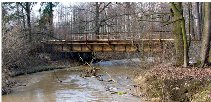
Fot. 5. Usytuowanie obiektu mostowego w lesie
