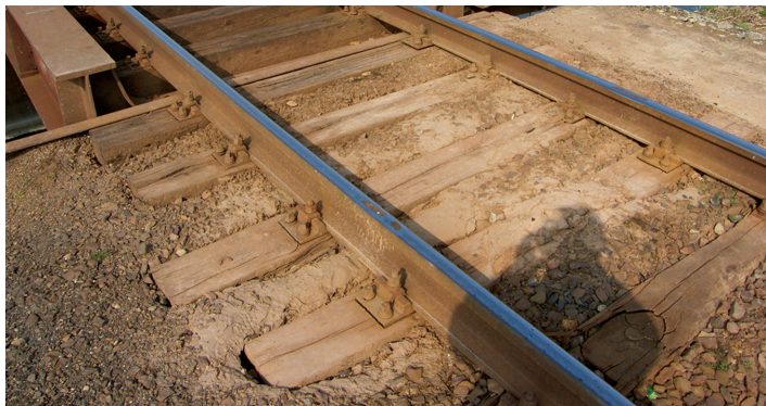
Fot. 9. Podmyte podkłady kolejowe przed wjazdem na obiekt
