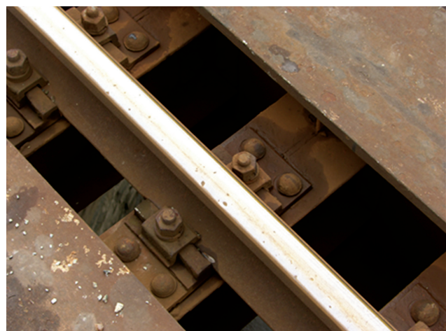
Fot. 4. Mocowanie szyn bezpośrednio do konstrukcji dźwigarów
