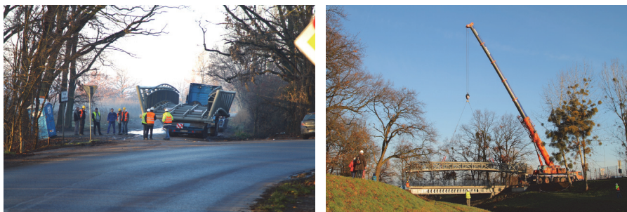
Rys. 9. Montaż kładki pieszo-rowerowej
