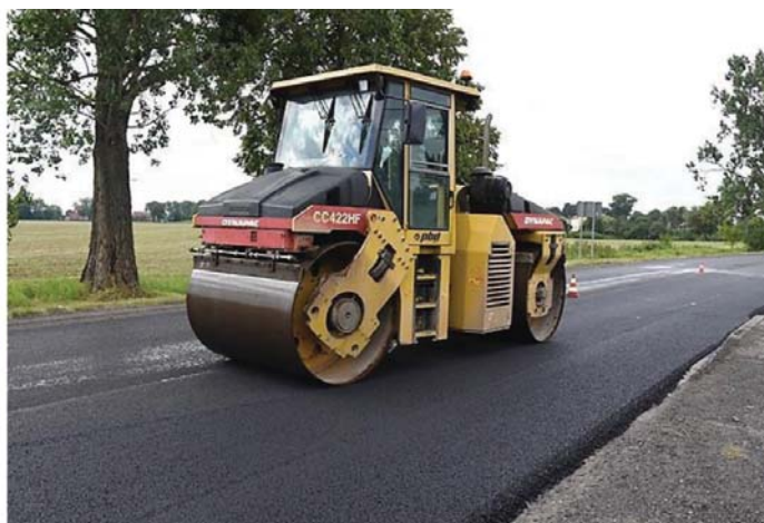
f) wałowanie warstw asfaltowych
