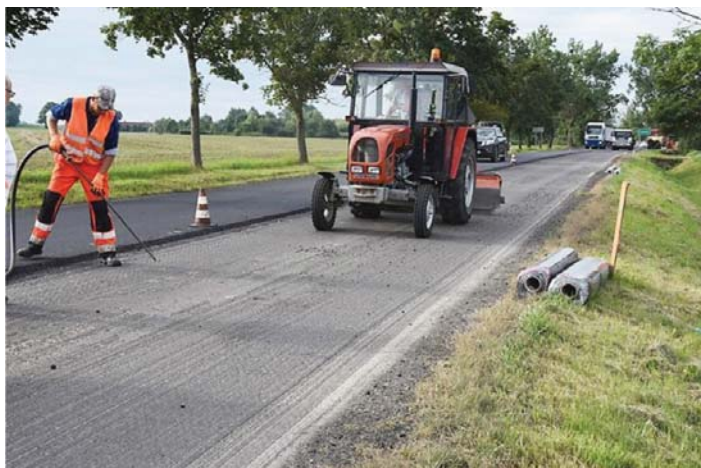
c) mechaniczne rozkładanie siatki z rolki
