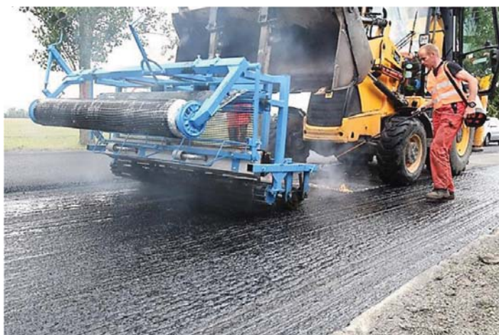
e) rozkładanie warstw asfaltowych
