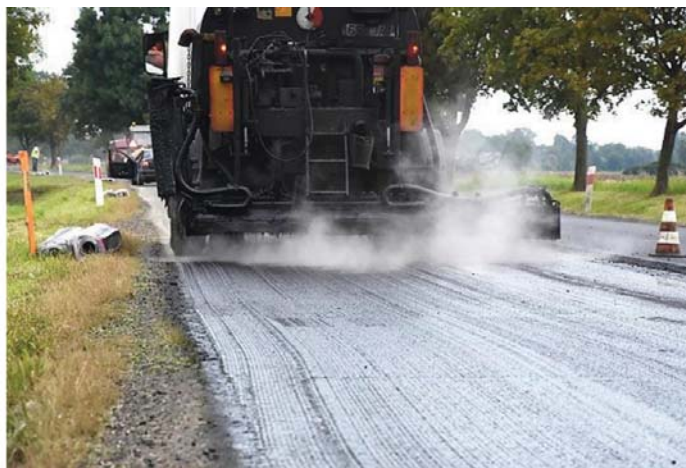
d) wbudowywanie mas asfaltowych na siatce
