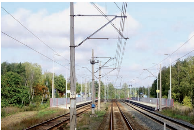
Rys. 13. Izolowane prześło naprężenia odłącznika nr 1 na prostej w Chociszewie przed przebudową stacji, 2019 [fot. D. Dratwa]
