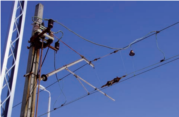
Rys. 6. Podwieszenie przy przerwie powietrznej z izolatorami w linii nośnej i drucie jezdnym; zachowany oryginalny izolator dzielczy ceramiczny i wieszak izolowany przez ceramiczny izolator odciążu jednokłozowy; sieć sKB70-C, Czachówek Południowy, 2018 [fot. D. Dratwa]
