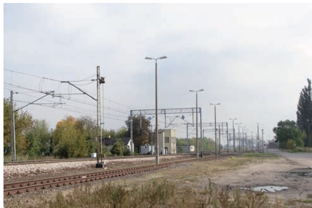
Rys. 5. (a) Sekcjonowanie sieci YwsC120-2C izolatorem sekcyjnym w miejscu, gdzie pociągi poruszają się z V_{max} 160 km/h, brak linii uelastyczniającej Y przy podwieszeniu izolatora, Jackowice, 2012; (b) izolator sekcyjny [fot. D. Dratwa]
