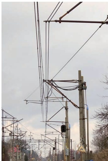
Rys. 9. Izolowane skrócone przęsło naprężenia sześciostupowe, sieć YC150-2C150, Zielonczyn, 2016 [fot. D. Dratwa]
