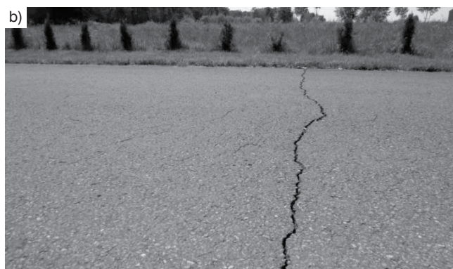
Rys. 1. Nawierzchnia drogowa przed oddaniem do użytku – odcinek doświadczalny w Ornontowicach (a) [6-8] oraz spękanie nawierzchni drogowej w Mysłowicach (b) (zdjęcia własne)
