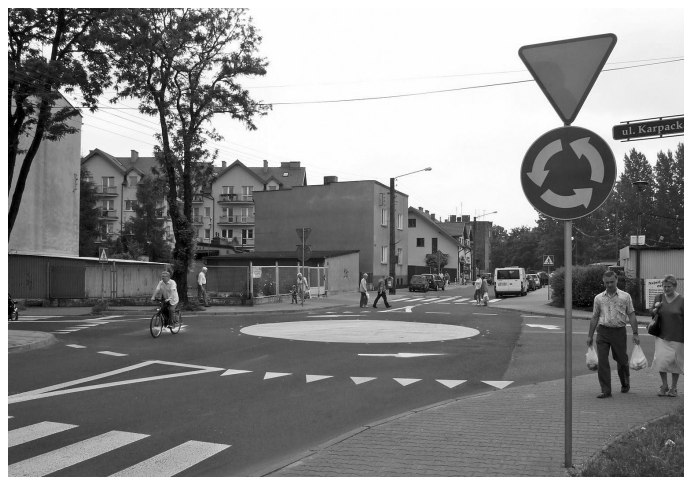
Fot. 4. Mini rondo na skrzyżowaniu ulic Granicznej, Karpackiej i Czempieła w Chorzowie
