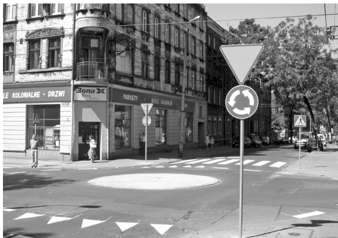
Fot. 5. Modernizacja skrzyżowania ulic 11 Listopada i Pudlarskiej w Chorzowie
