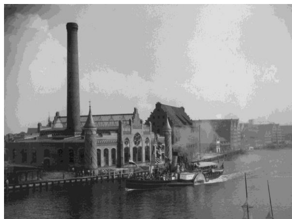
Fot. 5. Elektrownia na Ołowiance w Gdańsku w 1898 roku [2]
