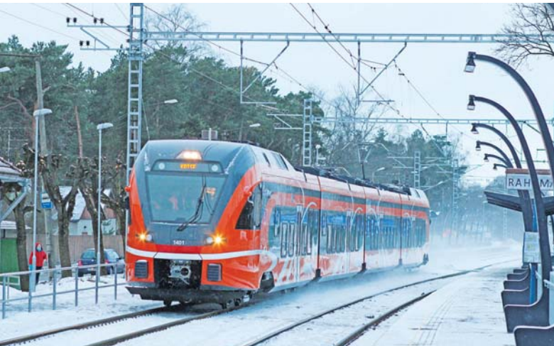
Elektryczny Flirt 1401 podczas prób na sieci EVR (3 kV DC, 1524 mm) w pobliżu stacji Rahumaä, w tle nowa sieć trakcyjna, Estonia (8.01.2013 r.). Fot. H. Pokk
