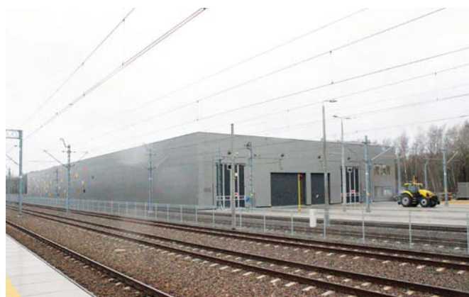
Centrum utrzymania Flirtów ŁKA w pobliżu dworca Łódź Widzew. Fot. A. Massel
