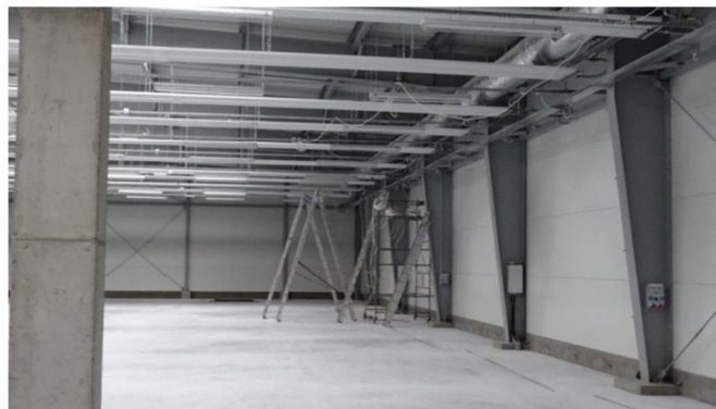
Rys. 3. Instalowanie podsufitowych promienników w trakcie robót
