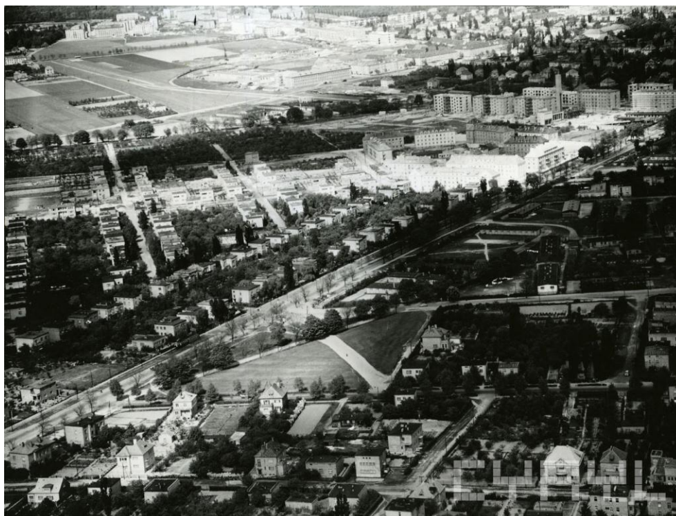
Rys. 1. Widok lotniczy dzielnicy Grunwald oraz ul. Grunwaldzkiej w drugiej połowie lat 40. XX w. W górnym lewym rogu modernistyczne osiedle willowe „Abisynia”. W prawym górnym rogu kwartał zabudowy przy ulicach Podstolińskiej i Cześnikowskiej. W panoramie bloki na osiedlu Grunwald przy ul. Grochowskiej z pierwszej połowy lat 60. XX w. [Cyryl 2023]
