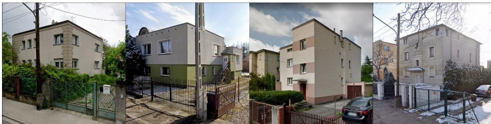
Rys. 9. Negatywne przykłady modernizacji budynków modernistycznych zlokalizowanych w dzielnicy „Abisynia” [opracowanie autorów]
