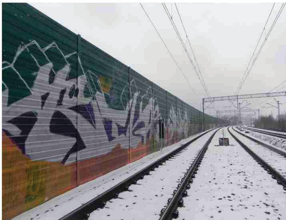
Rys. 5. Ekran akustyczny w Gdyni Orłowie, linia kolejowa E65
