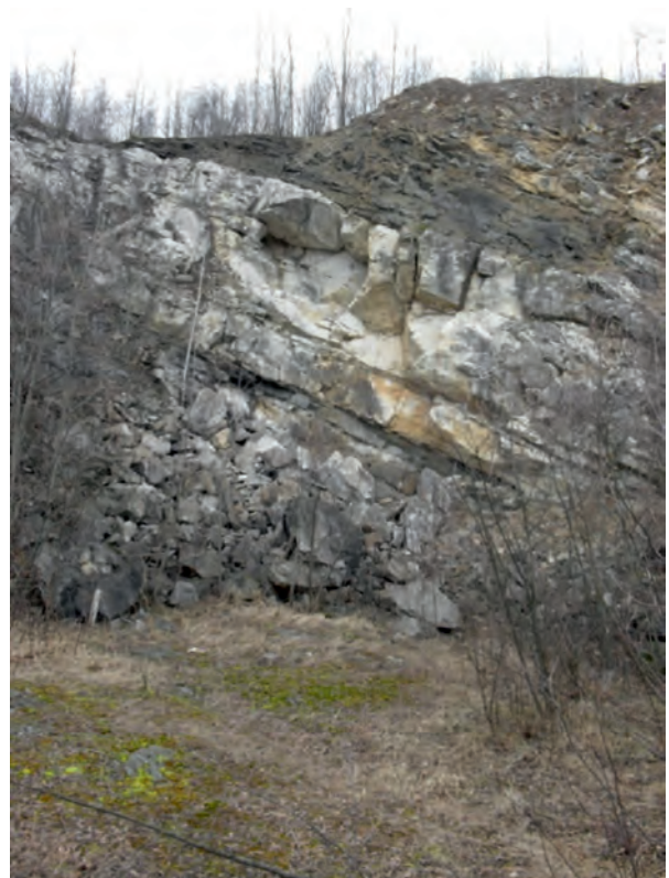
Rys. 5. Kamieniołom wschodni. Widoczne wyraźne nachylenie ławic marmuru Fig. 5. East quarry. Visible distinct inclination of marble strata
