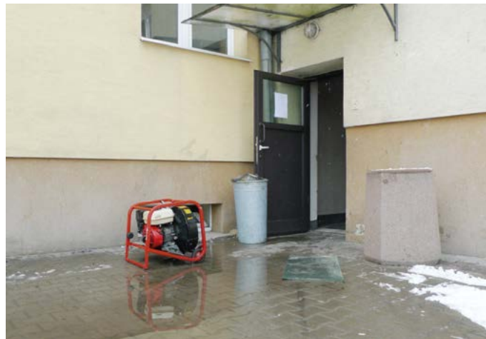
Figure 8. Trashcan blocking the possibility of closing the aeration opening Rycina 8. Kosz na śmieci blokujący możliwość zamknięcia otworu napowietrzającego Source: Own elaboration. Źródło: Opracowanie własne.
