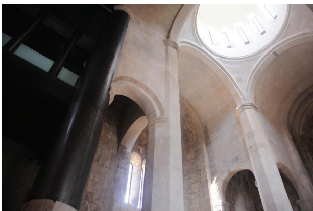
Il. 6. Katedra Bagrata, wewnątrz, widok konstrukcji empyry nawy północnej (fot. Z. Świechowski, 2014)
