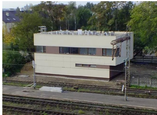
Fot. 5. Nastawnia komputerowa działająca na stacji Łuków
