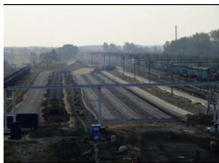
Fot. 2. Przebudowa stacji Łuków – początkowe działania – przebudowa torowiska
