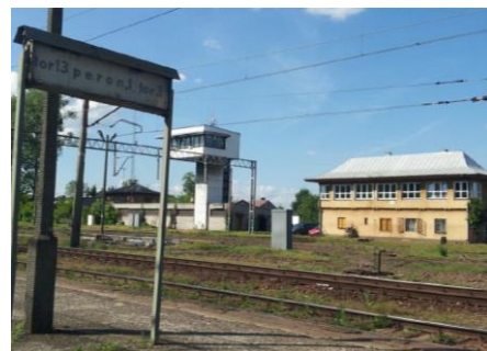
Fot. 3. Nastawnia urządzeń PB z częścią manewrową na stacji Łuków
