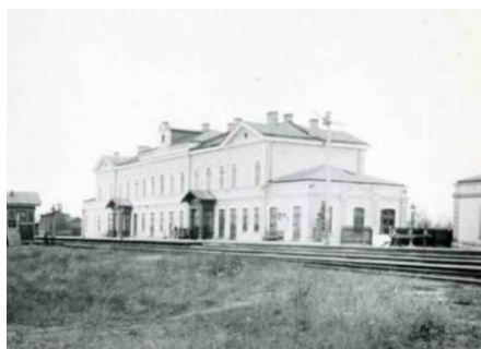
Fot. 1. Budynek dworca kolejowego w Łukowie – fasada od strony torów w latach 30-tych XX wieku [9]
