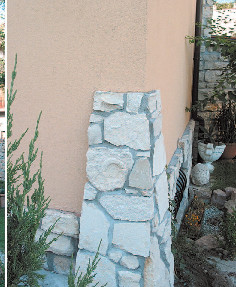
▲ Fragment wykończenia narożnika – wapień tyniecki. Dom jednorodzinny, Kraków (arch. W. Kocjan, wykonanie „Portico”). Fragment of a corner – Tynec limestone. Single-family house, Cracow (arch. W. Kocjan, implemented by “Portico”).
