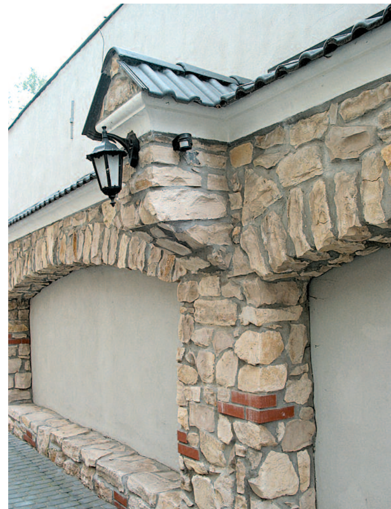
▼ Rekonstrukcja starego muru przy ulicy Kociuszki, Kraków (arch. W. Kocjan, wykonanie „Portico”). Reconstruction of an old wall in Kociuski Street, Cracow (arch. W. Kocjan, implemented by “Portico”).
