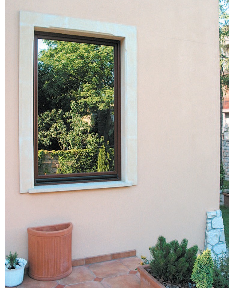
▲ Obramienie okienne – piaskowiec. Dom jednorodzinny, Kraków (arch. W. Kocjan, wykonanie „Portico”). Window frame – sandstone. Single-family house, Cracow (arch. W. Kocjan, implemented by “Portico”).
