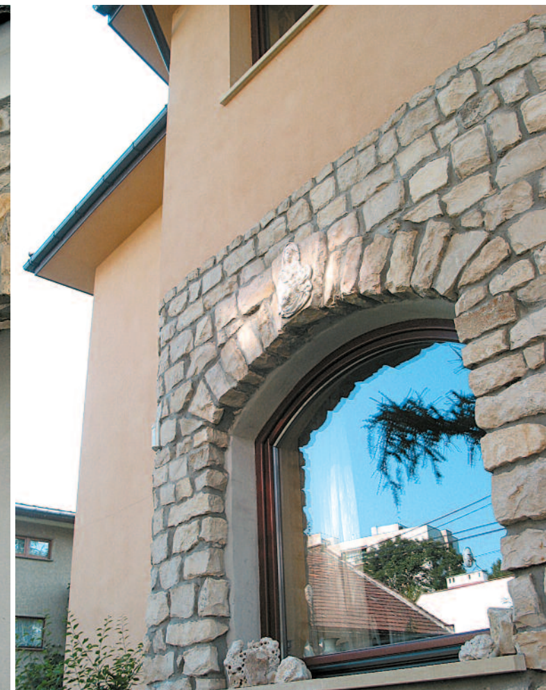
▼ Obramienie okienne. Dom jednorodzinny, Kraków (arch. W. Kocjan, wykonanie „Portico”). Window frame. Single-family house, Cracow (arch. W. Kocjan, implemented by “Portico”).
