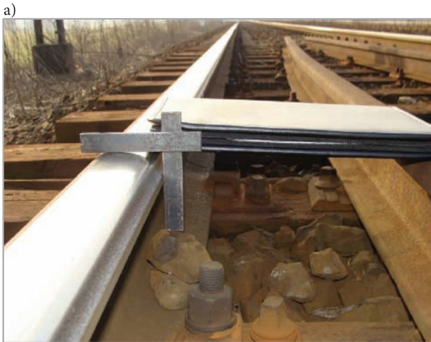
Rys. 8. Zużycie boczne główki szyny na wjeździe na obiekt od strony stacji Otok: a) pomiar zużycia, b) widok z boku, widoczne opiłki świadczące o silnym tarcu [fot. R. Chmielewski]
