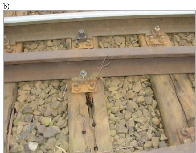
Rys. 7. Przykłady uszkodzeń nawierzchni: a) na obiekcie, b) na dojeździe [fot. R. Chmielewski]
