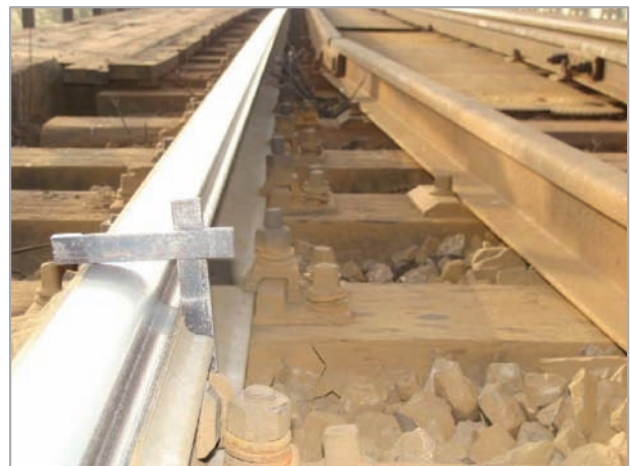
Rys. 10. Zużycie boczne główki szyny na końcu drugiego przęsła, od strony stacji Otok [fot. R. Chmielewski]
