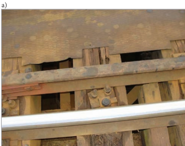
Rys. 7. Przykłady uszkodzeń nawierzchni: a) na obiekcie, b) na dojeździe [fot. R. Chmielewski]
