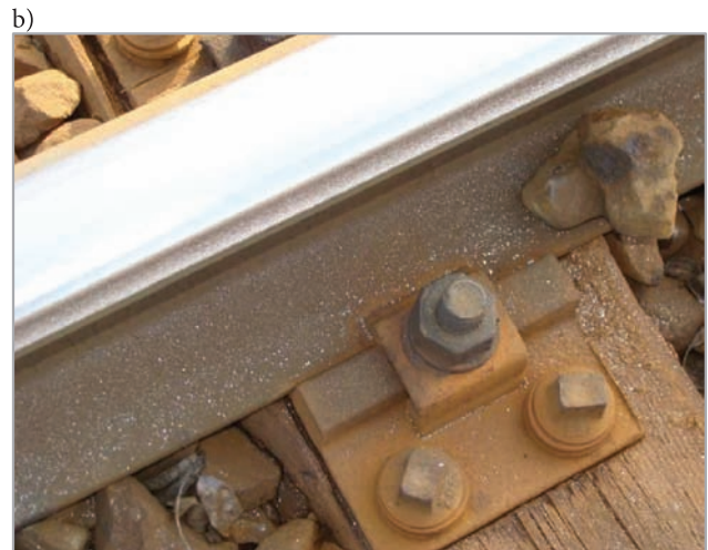
Rys. 8. Zużycie boczne główki szyny na wjeździe na obiekt od strony stacji Otok: a) pomiar zużycia, b) widok z boku, widoczne opiłki świadczące o silnym tarcu [fot. R. Chmielewski]
