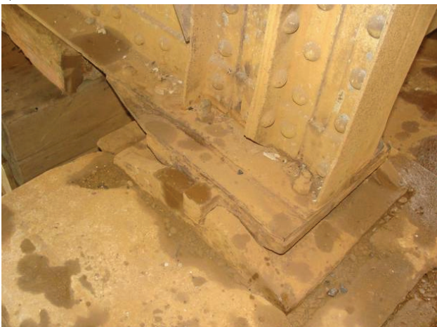
Rys. 1. Stan strefy podporowej: a) w osi nr I po stronie lewej przęsła, b) osi nr II po stronie lewej przęsła, c) w osi nr III po stronie lewej przęsła, d) w osi nr IV po stronie prawej przęsła [fot. R. Chmielewski]
