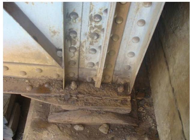
Rys. 1. Stan strefy podporowej: a) w osi nr I po stronie lewej przęsła, b) osi nr II po stronie lewej przęsła, c) w osi nr III po stronie lewej przęsła, d) w osi nr IV po stronie prawej przęsła [fot. R. Chmielewski]
