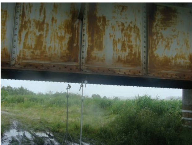
Rys. 5. Czujniki przemieszczeń ustawione pod przęsłem [fot. R. Chmielewski]
