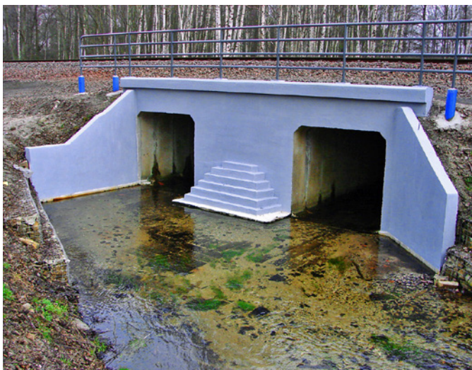
Ryc. 4. Przykład dwuotworowego przepustu skrzynkowego pod magistralną linią kolejową, fot. Z. Kubiak
