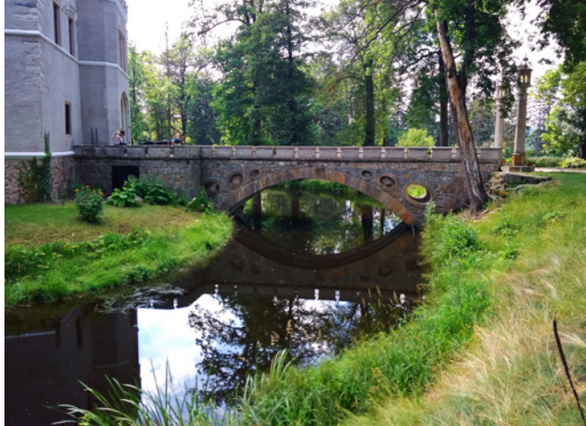
Ryc. 1. Przykład zastosowania dodatkowych otworów w ścianach bocznych historycznego obiektu nad fosą w zamku w Karpnikach, fot. J. Howis
