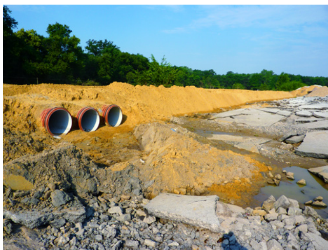
Ryc. 8. Przykład zastosowania przepustu wielootworowego w trakcie realizacji odbudowy drogi wojewódzkiej, która uległa zniszczeniu podczas powodzi, fot. A. Wysokowski
