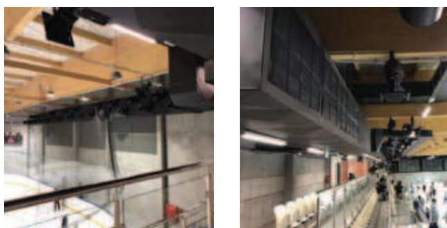
Rys. 5. Lokalizacja dysz dalekiego zasięgu oraz krat wywiewu powietrza (źródło: fotografie własne autora)
