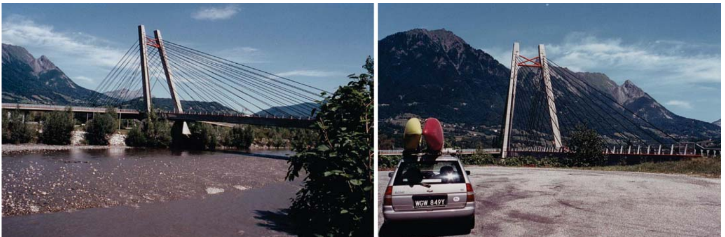
Fot. 2. Stalowy rygiel mostu podwieszonoego we francuskich Alpach
