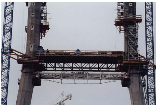
Fot. 1. Fazy budowy górnych rygli mostu Siekierkowskiego w Warszawie: a) rozpory pochyle słupów pylonu i kratownica do oparcia szalunków na pylonie lewobrzeżnym, b) rozpóra górna i kratownica – zbliżenie, c) rozpory i kratownica na pylonie prawobrzeżnym; w głębi ukończony rygiel pylonu lewobrzeżnego
