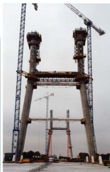
Fot. 1. Fazy budowy górnych rygli mostu Siekierkowskiego w Warszawie: a) rozpory pochyle słupów pylonu i kratownica do oparcia szalunków na pylonie lewobrzeżnym, b) rozpóra górna i kratownica – zbliżenie, c) rozpory i kratownica na pylonie prawobrzeżnym; w głębi ukończony rygiel pylonu lewobrzeżnego
