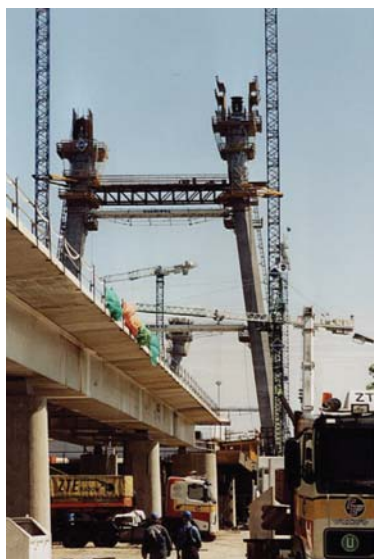
Fot. 1. Fazy budowy górnych rygli mostu Siekierkowskiego w Warszawie: a) rozpory pochyle słupów pylonu i kratownica do oparcia szalunków na pylonie lewobrzeżnym, b) rozpóra górna i kratownica – zbliżenie, c) rozpory i kratownica na pylonie prawobrzeżnym; w głębi ukończony rygiel pylonu lewobrzeżnego
