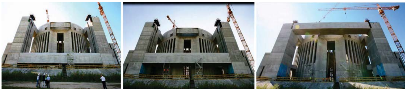
Fot. 3. Podnoszenie żelbetowych rygli wieńczących portale Świątyni Opatrzności w Warszawie (zdjęcia z budowy świątyni pochodzą z archiwum przedsiębiorstwa Warbud S.A.).
