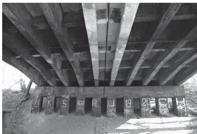
Rys. 4. Widok wiaduktu od spodu, od strony północnej, widoczne główne elementy konstrukcyjne: podłużne belki główne, poprzecznice oraz filary Fig. 4. View of the bridge from below, from the north, the main structural elements are visible
