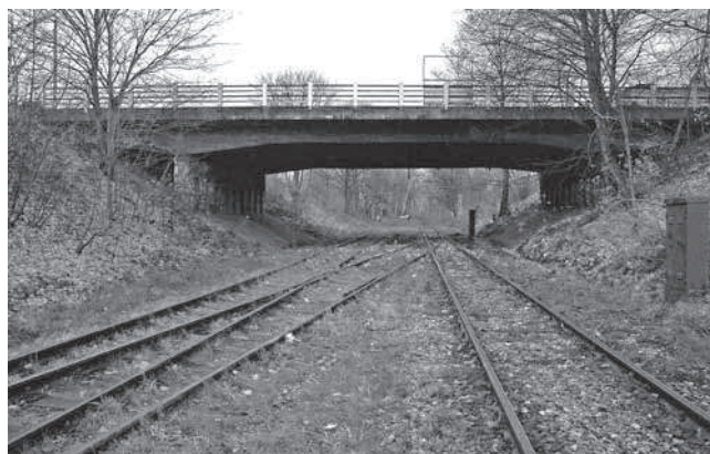
Rys. 1. Widok wiaduktu od strony południowo-wschodniej, wzdłuż torów kolejowych
