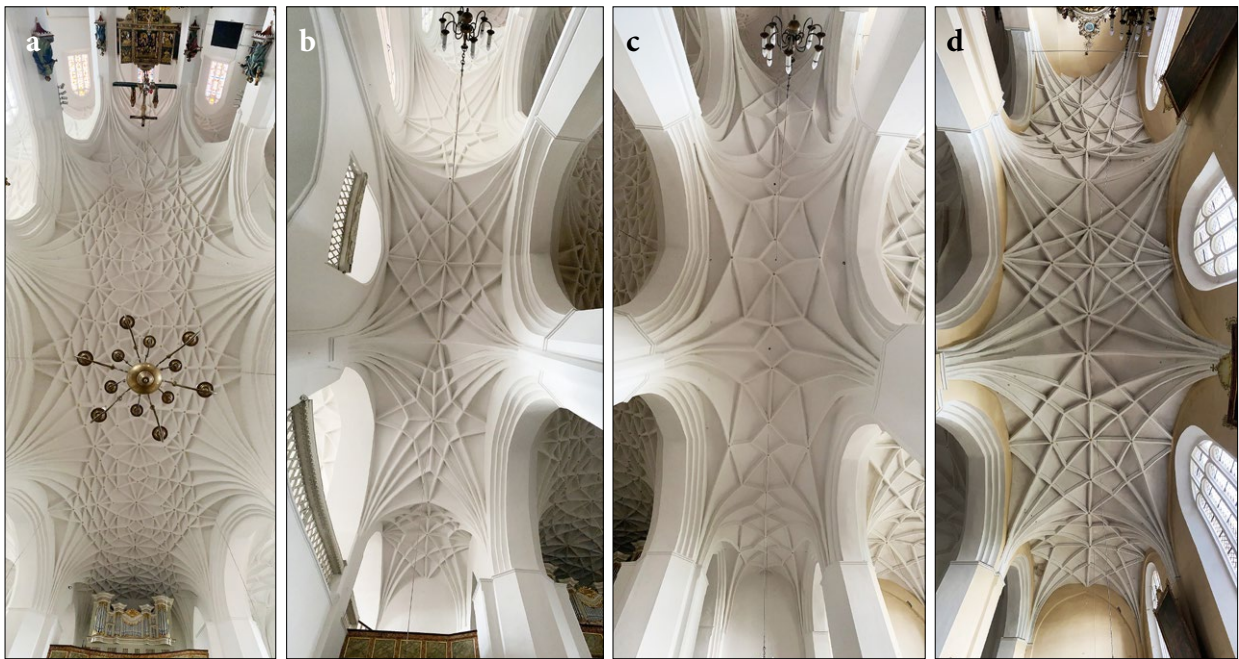
Ryc. 7. Kościół parafialny pw. św. Michała Archanioła; a) sklepienia nawy głównej; b) sklepienia nawy południowej; c) sklepienia nawy północnej; d) sklepienia nawy skrajnej północnej; fot. autor
