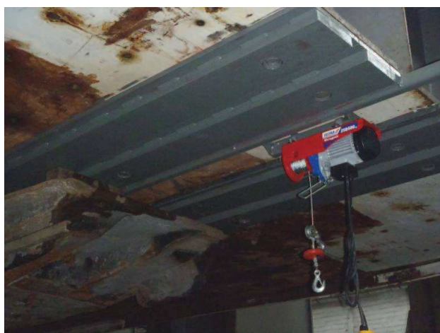
Rys.10. Widok wzmocnienia stropu stanowiska badawczego [13]
