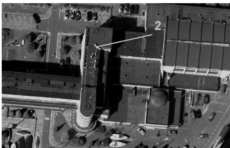
Fot. 5. Rozmieszczenie anten radarów Raytheon NSC34 (nr 1) i FM-CW CRM-203 (nr 2) na dachu budynku Wydziału Nawigacyjnego Akademii Morskiej w Gdyni
