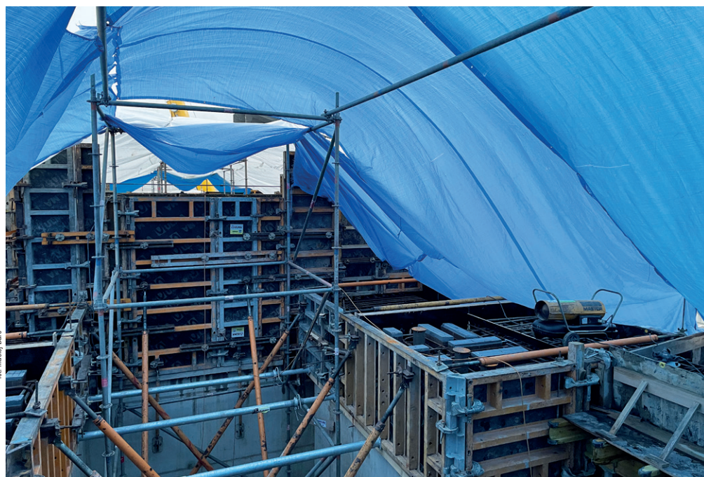
Przygotowania do zimowego betonowania
