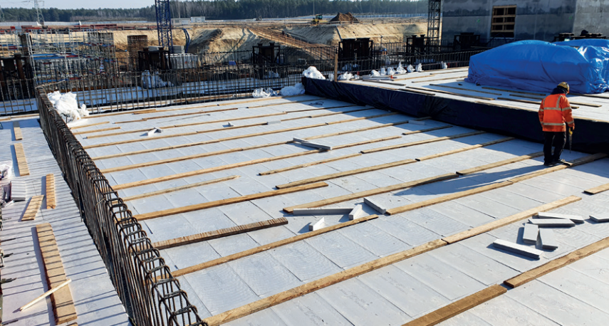
Szczelna izolacja termiczna na masywnej płycie fundamentowej
