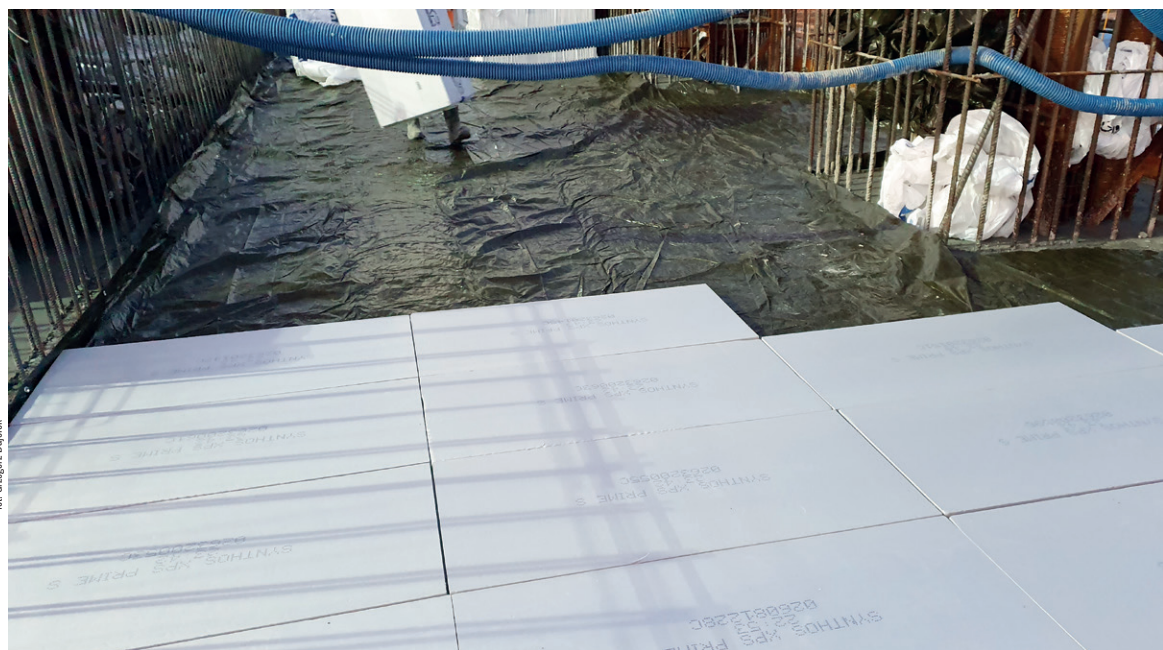
Układanie warstw izolacyjnych na masywnej płycie fundamentowej
