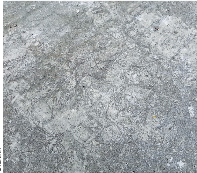
Przemrożona powierzchnia płyty betonowej
