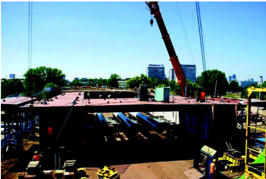
Fot. 1. Montaż nowej konstrukcji na opuszczonej płycie pomostu
