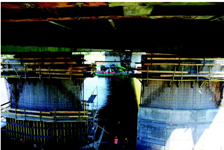
Fot. 3. Naprawa filarów przez nałożenie płaszcza żelbetowego
