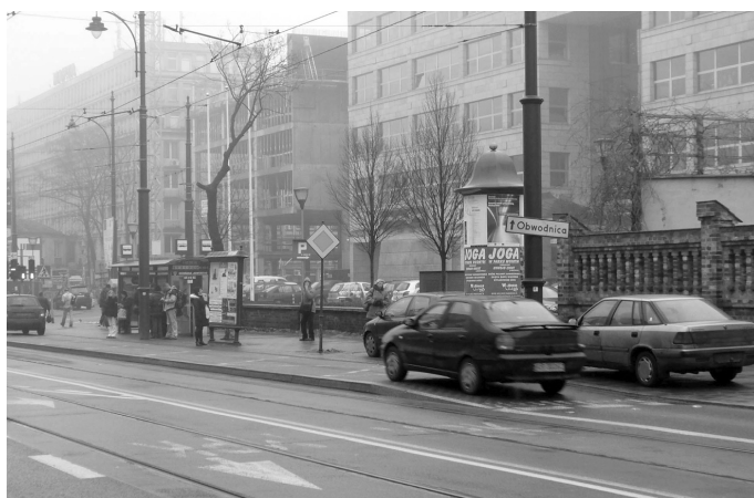
Fot. 2. Podniesienie poziomu jezdni na długości przystanku.
