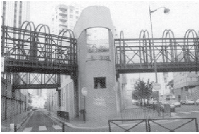
Fot. 1. Dwupoziomowa segregacja ruchów. Narożnik na kącie ostrym przy Rue Jean-Zay w Paryżu
