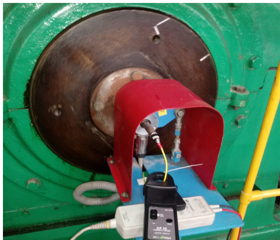
Rys. 6. Pomiar prądu poprzez złącze obrotowe
