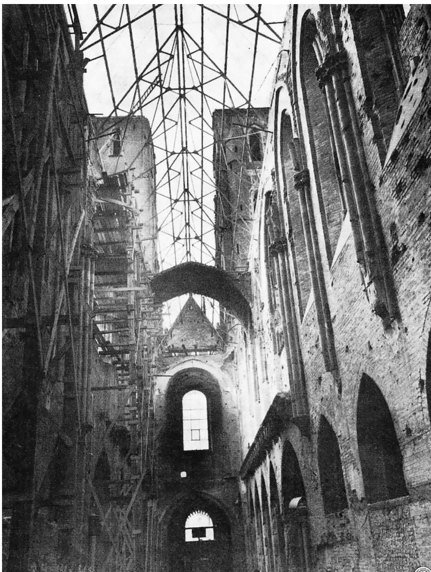
Fot. 4. Nowa więźba stalowa katedry. Stan z wiosny 1948 r., [w:] Panorama kultury współczesnego Wrocławia, red. B. Zakrzewski, Zakład Narodowy im. Ossolińskich, Wrocław 1970; źródło internetowe: https://polska-org.pl/4604458,foto.html?idEntity=508858 [dostęp: 30.08.2021]
