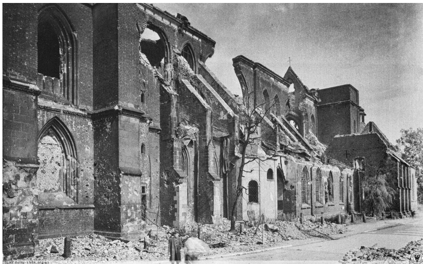
Fot. 2. Zniszczenia wojenne elewacji południowej 1945 r., fot. Krystyna Gorazdowska; źródło: https://polska-org.pl/6546245,foto.html [dostęp: 30.08.2021]
