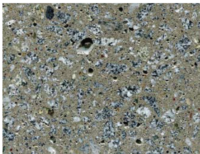
Rys. 7. Zgląd próbki betonowej
