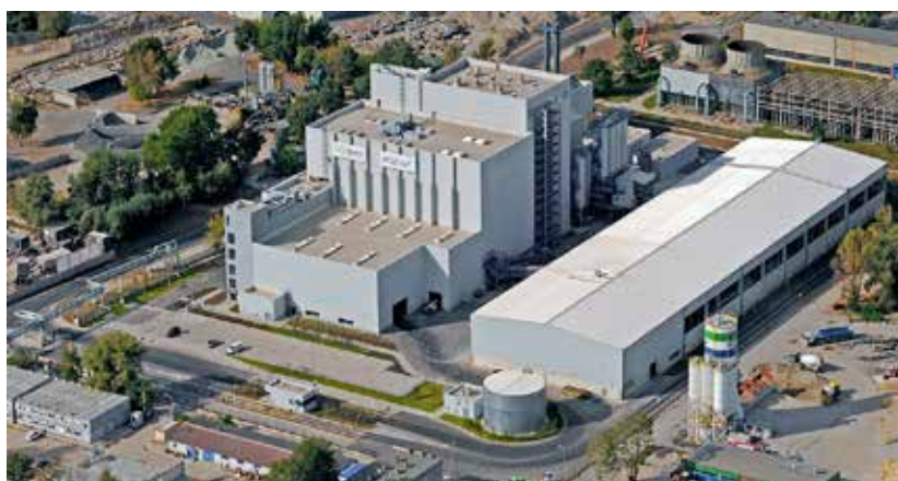
Rys. 8. Spalarnia odpadów komunalnych w Poznaniu
