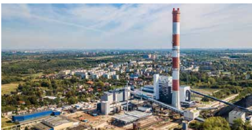
Rys. 14. Elektrociepłownia FORTUM w Zabrze z kotłem wielopaliwowym
