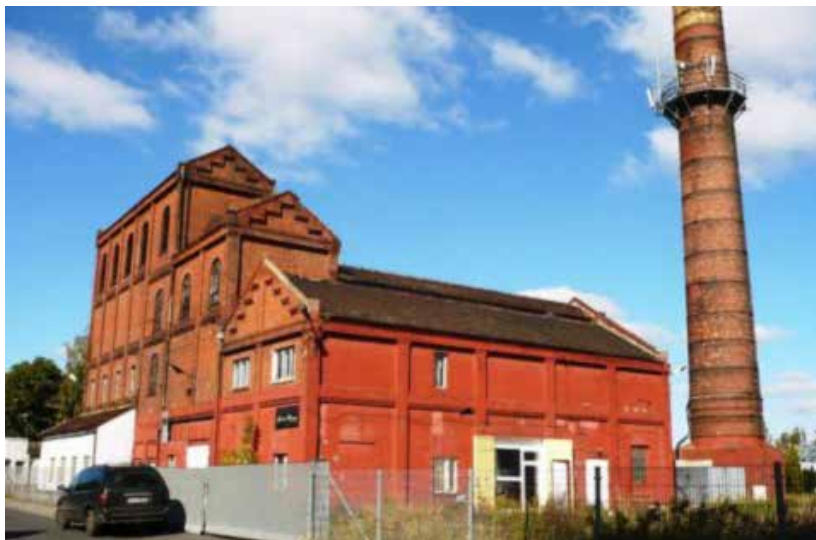
Rys. 1. Pierwsza poznańska spalarnia odpadów komunalnych „na Wilczaku”
