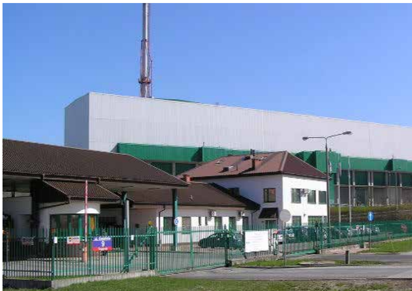
Rys. 2. Spalarnia odpadów komunalnych w Warszawie
