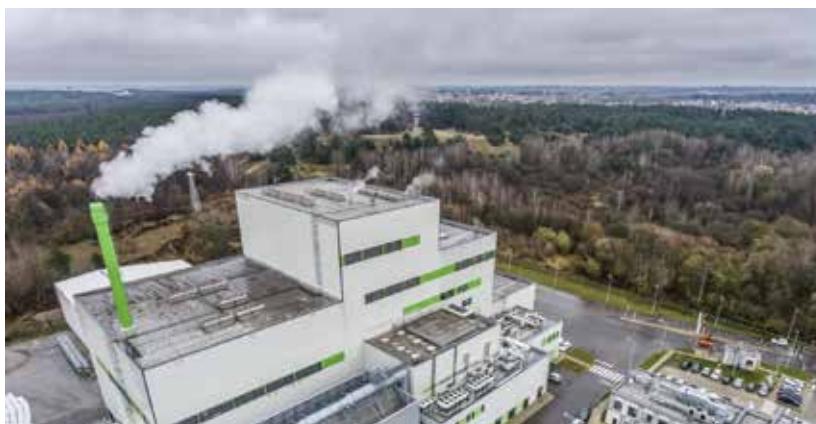
Rys. 4. Spalarnia odpadów komunalnych w Białymstoku
