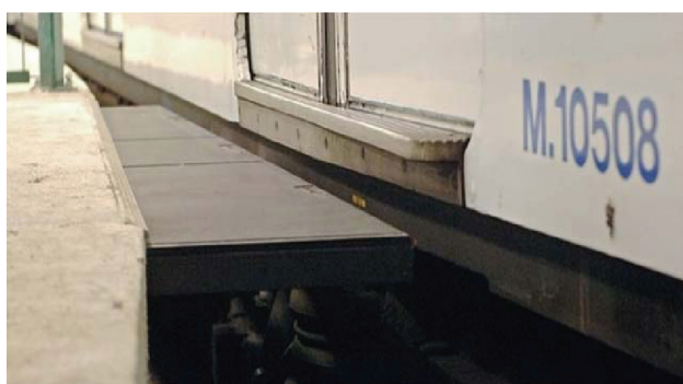
Rys. 13. Podest wysuwany z peronu [1]
