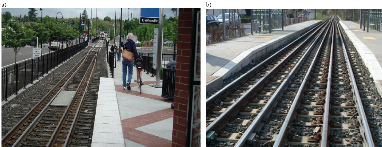
Rys. 10. Torzy zbliżone: a) Portland – USA [9], b) Kaufungen – Niemcy [17]
