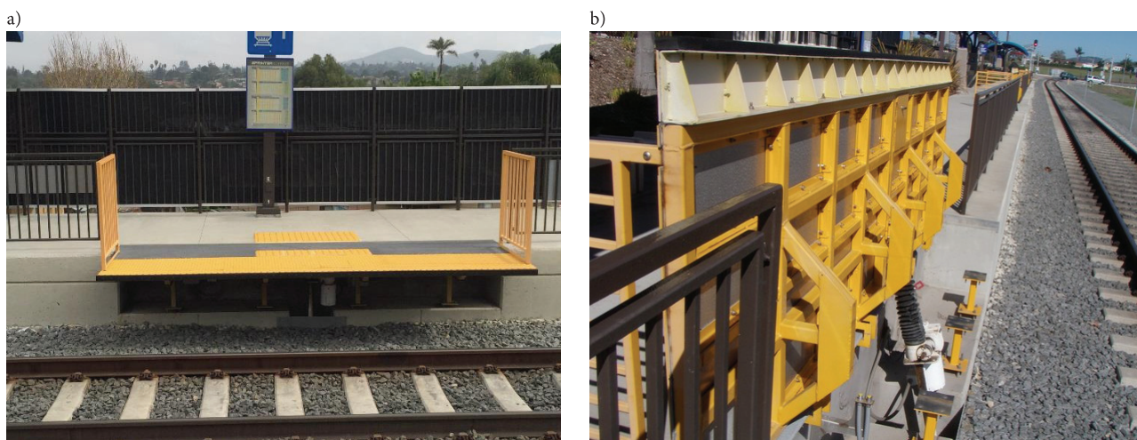
Rys. 12. Widok rozłożonej kładki (a) [4], kładka złożona (b) [20]
