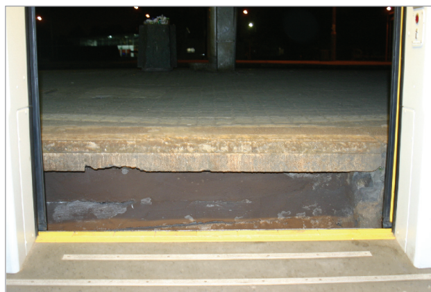
Rys. 5. Podłoga wagonu poniżej krawędzi peronu [fot. P. Gondek]
