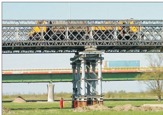
Rys. 3.1. Próbné obciążenie mostu objazdowego w m. Kiezmark przed dopuszczeniem do eksploatacji
