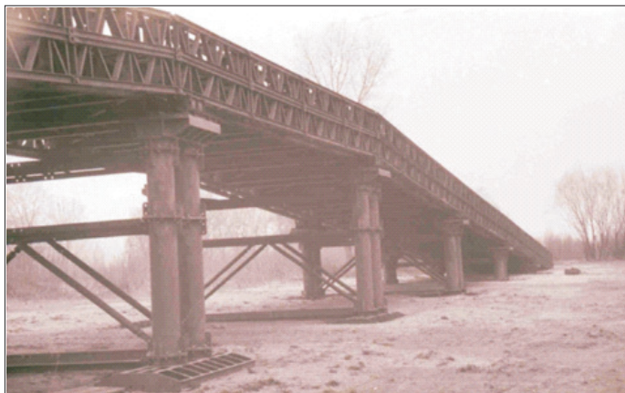
Rys. 2.4. Konstrukcja wiaduktu SWD-83 na podporach SPS-69B [4]
