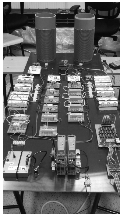
Rys. 1. Wygląd stanowiska badawczego do testowania łączników wysokonapięciowych
