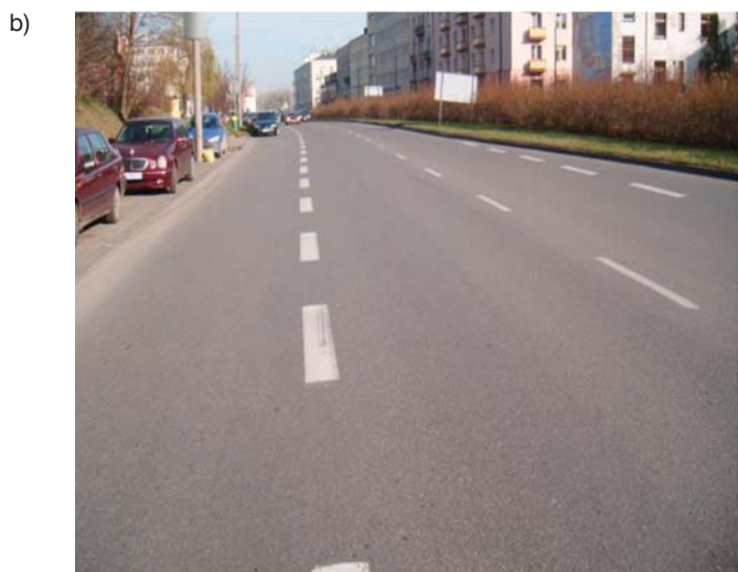
Fot. 3 Barwa nawierzchni asfaltowej; a) ciemna (kruszywo bazaltowe w mma), b) jasna (kruszywo z piaskowca kwarcytowego w mma)
