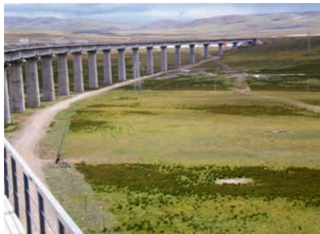
Ryc. 6. Estakada na linii dużych prędkości Wuhang – Guangzhou w Chinach, fot. A. Massel
