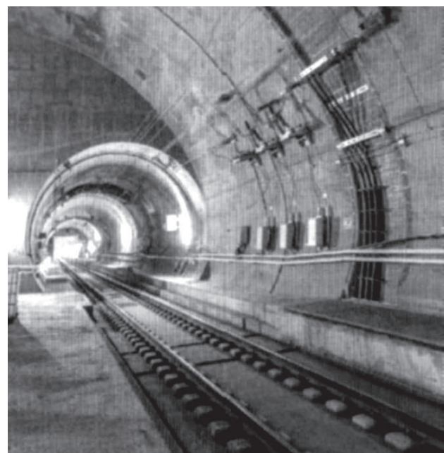
Ryc. 4. Widok tunelu św. Gotarda; źródło: materiały informacyjne Kummeler + Matter AG
