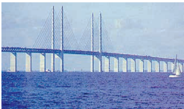
Ryc. 2. Łądowe połączenie Danii ze Szwecją: schemat trasy i widok mostu drogowo-kolejowego [8]
