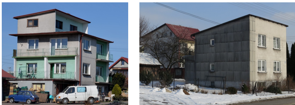
Ryc. 5, 6. Charakterystyczne formy budynków mieszkalnych z końca lat 70-tych, z różnych miejsc woj. małopolskiego (fot. H. Mełges)
