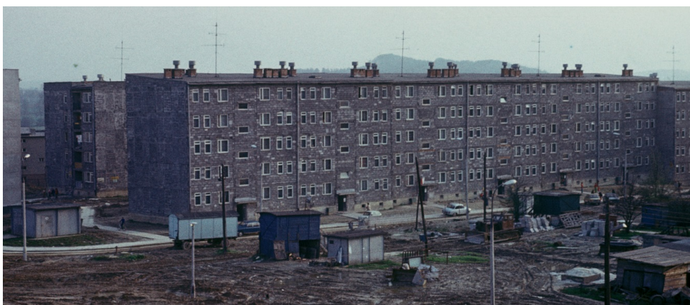
Ryc. 4. Fragment zabudowy wielorodzinnej z osiedla w Krzeszowicach z końca lat 70-tych. Wzory tych technologii budowlanych i materiałowych, często były wykorzystywane w budownictwie jednorodzinym w skali całej Polski (fot. H. Mełges)
