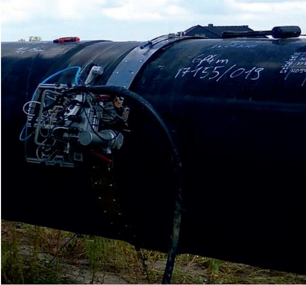
Rys. 3. Zmechanizowany system TOFD +PE z układem prowadzenia na taśmie Crossa.
