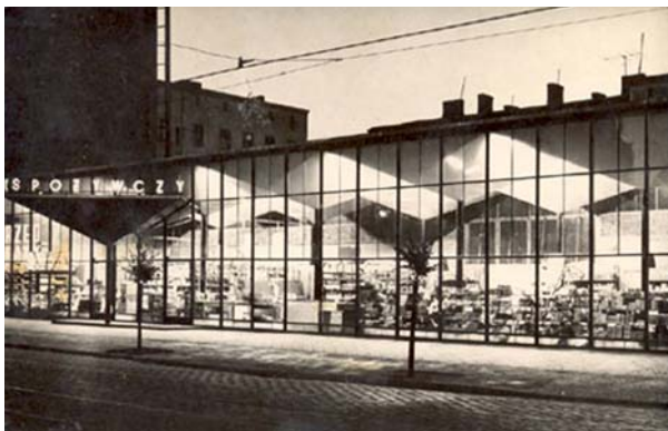
Ryc. 1. Pawilon handlowy „Barbara” rozebrany w 2002 r. i zastąpiony nowym budynkiem usługowo-mieszkalnym. Źródło: http://sedina.pl/galeria/thumbnails.php?album=884
