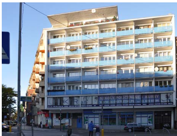
Ryc. 6. Budynek mieszkalno-usługowy, ul. Wojska Polskiego, ujęty na listach dóbr kultury współczesnej, 2016. Źródło: I. Kozłowska
