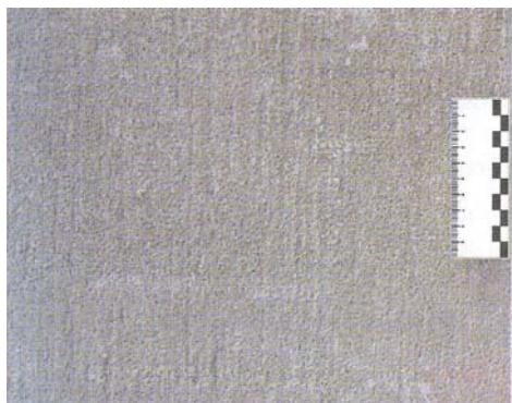
Fot. 3. Teksturowanie nawierzchni tkaniną jutową po naniesieniu środka do pielęgnacji powierzchniowej (str. prawa – widok w powiększeniu)
