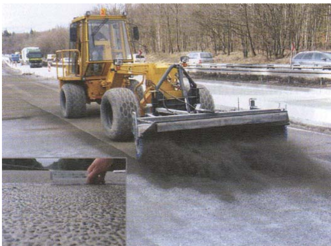
Fot. 5. Usuwanie zaprawy powierzchniowej
