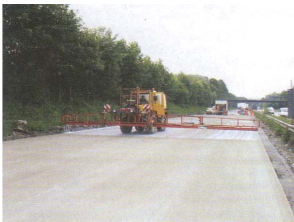
Fot. 6. Drugi zabieg pielęgnacyjny obejmujący użycie płynnego środka do pielęgnacji betonu
