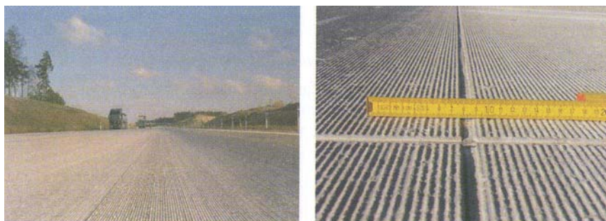
Fot. 12. Tekstura po wykonaniu szlifowania ( grinding ) – str. lewa widok ogólny, str. prawa: zbliżenie widoku nawierzchni
