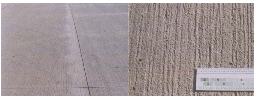
Fot. 11. Tekstura uzyskana po przeciągnięciu tkaniny jutowej (po prawej stronie – szczegół wykonania)
