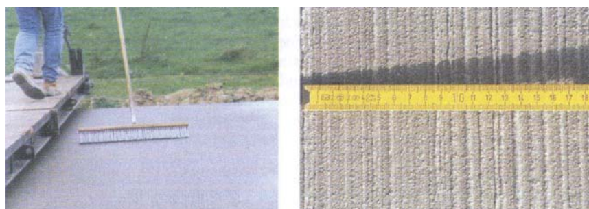
Fot. 9. Teksturowanie poprzeczne (str. lewa: teksturowanie sposobem ręcznym z użyciem szczotki stalowej; str. prawa: uzyskana jednolita tekstura poprzeczna)
