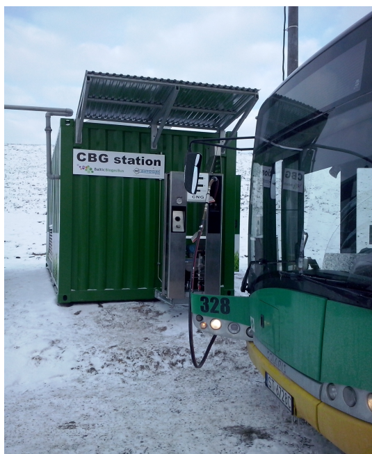
Rys 2. Moduł II - tankowanie autobusu biometanem
