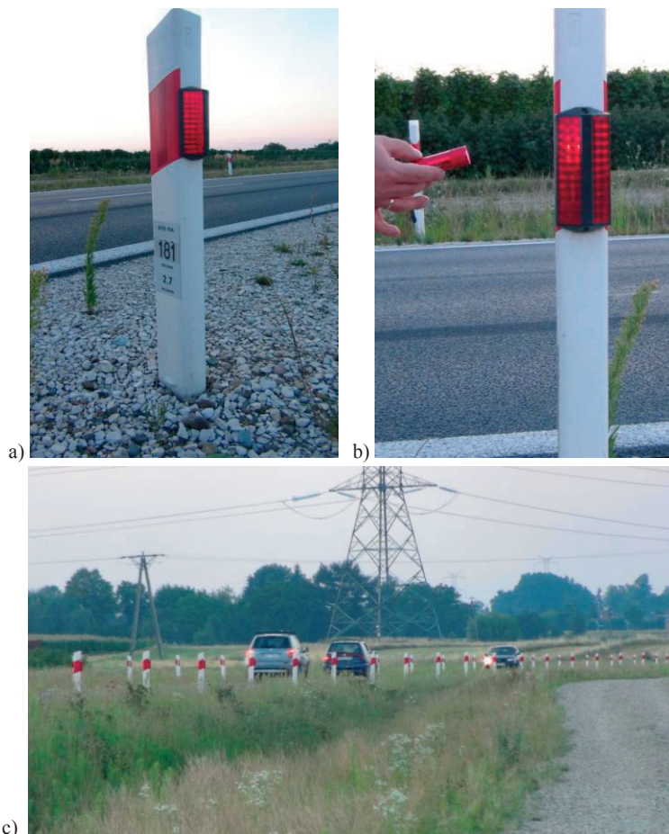
Fot. 1. a, b, c. Zastosowane wilcze oczy wzdłuż nowo wybudowanej drogi, fot. J. Bohatkiewicz
