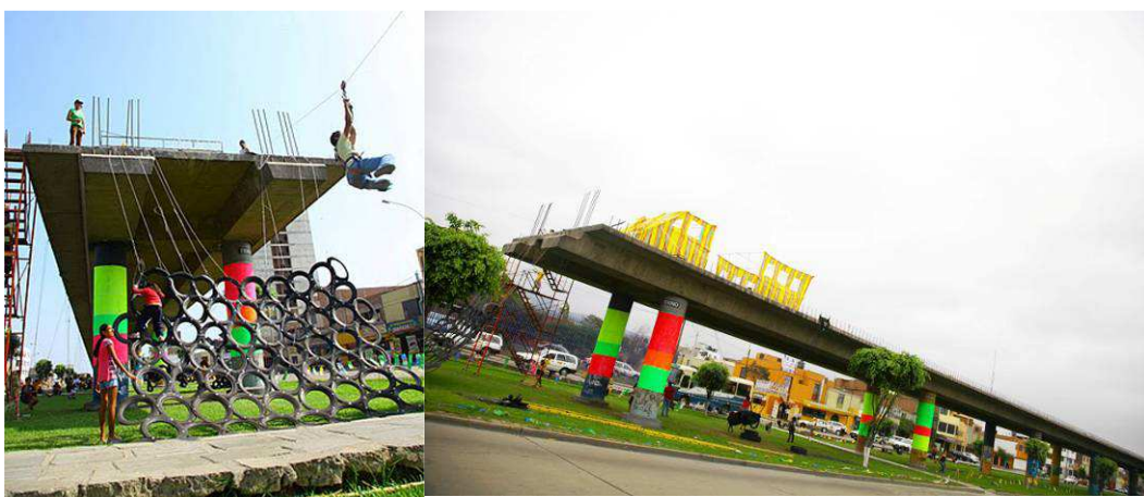
Ryc.10. Peru. Lima. Basurama (Playground) czyli Park Pociągu-Widma ( Ghost Train Park ) 2010. Jest uroczym, bezpretensjonalnym przedsięwzięciem ludycznym - wykorzystuje porzuconą estakadę. Nawiązuje do parków miejskich na koronie dawnych konstrukcji kolejowych - w Paryżu i na Manhattanie (słynna High-Line). a-dynamiczne ujęcie - poprzeczne do rzeki. b- kontekst przedmieścia. Źródło:www.play-space.com Fig. 10. Peru. Lima. Basurama (Playground) Ghost Train Park 2010. Source: www.play-space.com
