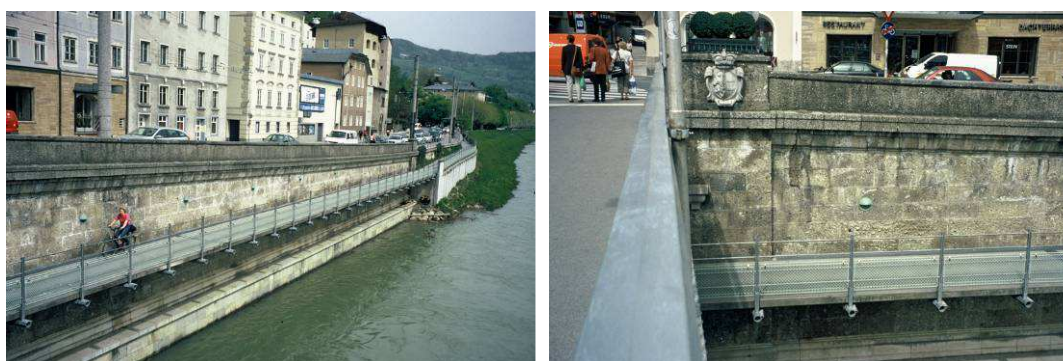
Ryc.8. Salzburg. Wybrzeże rzeki Salzach. Nowoczesne wspornikowe trasy rowerowe w stylu wysokiej technologii high-tech , są umocowane w zabytkowym murze służącym regulacji przeciwpowodziowej. a-odcinek na peryferiach miasta; trasa rowerowa wnika z normalnego odcinka pozamiejskiego przy jezdni, w formie łagodnie pochylonej rampy - do miasta. b-odcinek śródmiejski: trasa rowerowa "nurkuje" pod mostem. Źródło: fot.aut.
