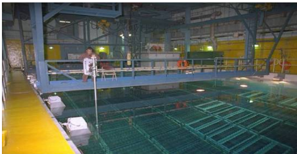
Fot. 4. Basen przechowawczy wypalonego paliwa Photo 4. Spent Fuel Bay
