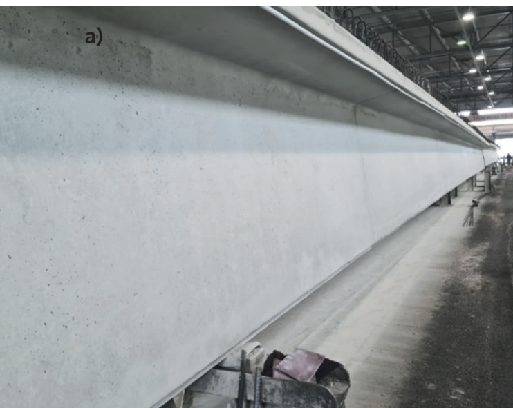
Fot. 1. Belki wykonane podczas próby przemysłowej z betonu z cementem: a) CEM I 52,5R (referencyjna), b) CEM III/A-LL 52,5R
