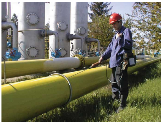
Rys. 1. Badania defektoskopowe elementów rurociągu
