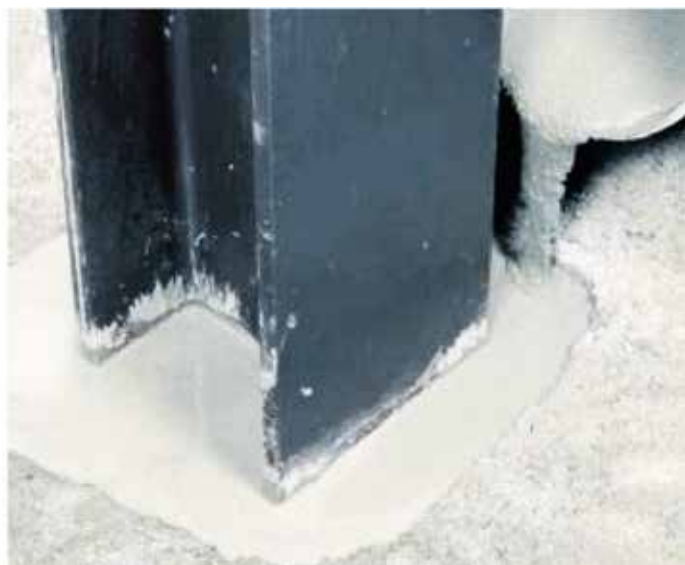
Rys. 14. Zastosowanie zapraw (szybkosprawna i do spoinowania) z wykorzystaniem klinkieru CSA [8]
