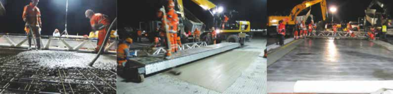
Rys. 12. Betonowanie na drodze dojazdowej na lotnisku w Zurychu
