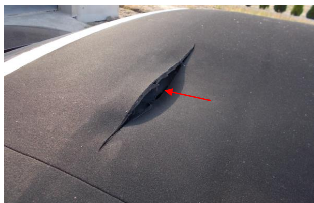
Rys. 5. Uszkodzenie poszycia dachu.
